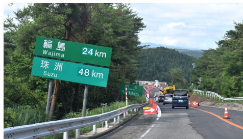
金沢市から穴水町へ至る幹線道路・のと里山海道は被害を受け復旧工事のため片側通行となっていたが報道によれば7月17日に対面通行が再開した=7月1日
