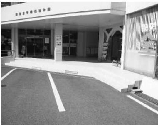
【県本部入口前駐車場2台(労金共用)】
